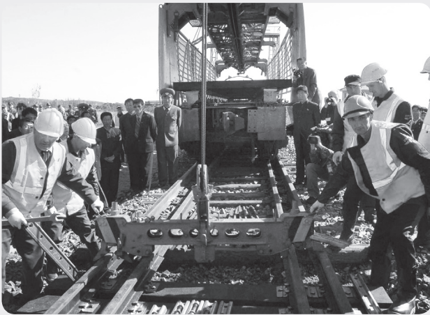
북·러 나진-하산 철도 현대화 공사
