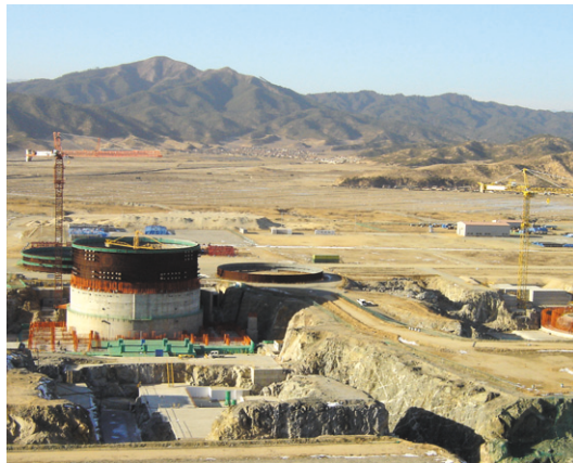
경수로발전소 건설 현장
