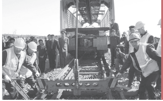
북·러 나진-हत산 철도 현대화 공사
