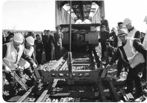
북·러 나진-함산 철도 현대화 공사
